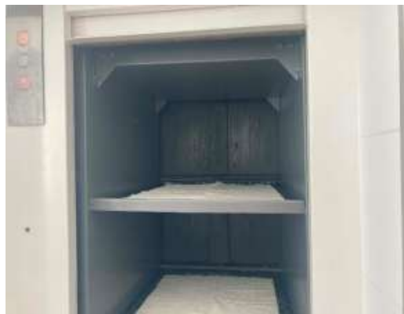
Wymiana wciągarki towarowej w Przedszkolu w Książu Wlkp. Całkowita wartość inwestycji: 30 290,00 zł
