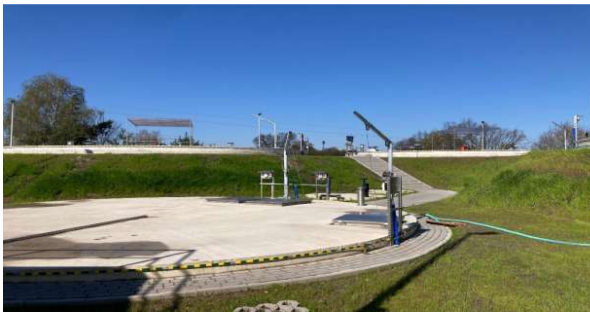
Modernizacja oczyszczalni ścieków-zbiornik ścieków i reaktory SBR 1 i SBR 2
