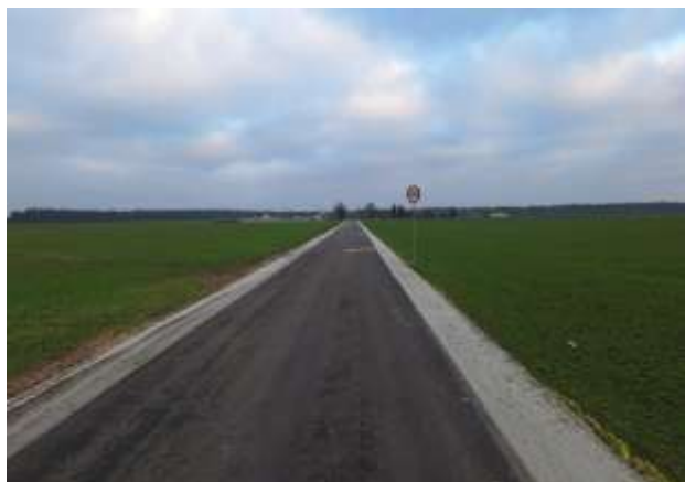
Przebudowa drogi do terenów inwestycyjnych Książ Wlkp. - Radoszkowo Całkowita wartość inwestycji: 6 340 843,53 zł Dofinansowanie: 6 023 801,35 zł
