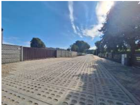
Przebudowa drogi w Łężku Całkowita wartość inwestycji: 269 026,31 zł
