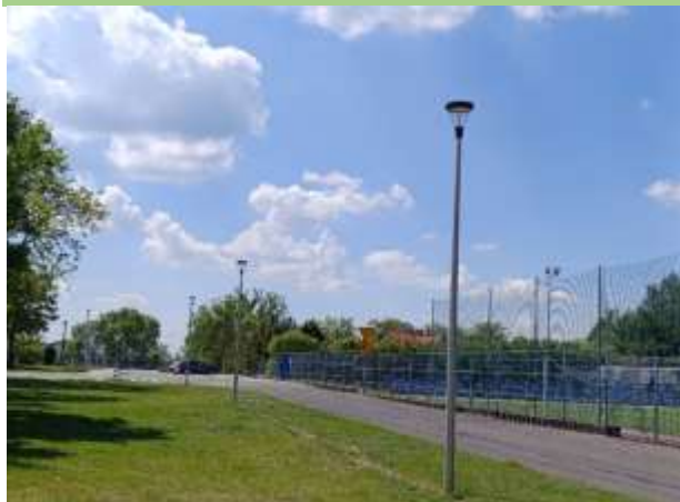
Rozbudowa oświetlenia przy Mogiłach w Książu Wlkp. Całkowita wartość inwestycji: 80 000,00 zł
