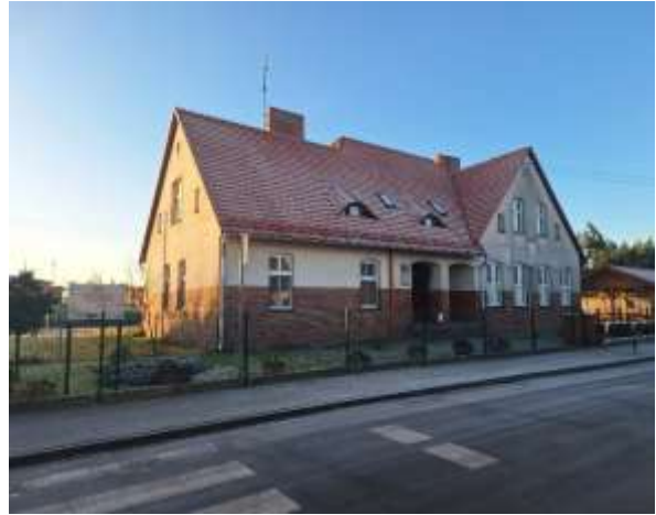
Remont dachu świetlicy środowiskowej w Zaborowie Całkowita wartość inwestycji: 386 345,30 zł
