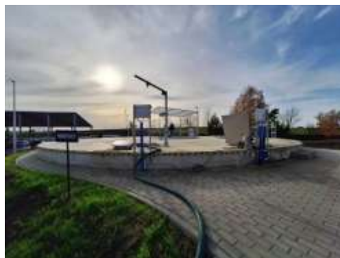
Rozbudowa i modernizacja oczyszczalni ścieków w Kiełczyńku
