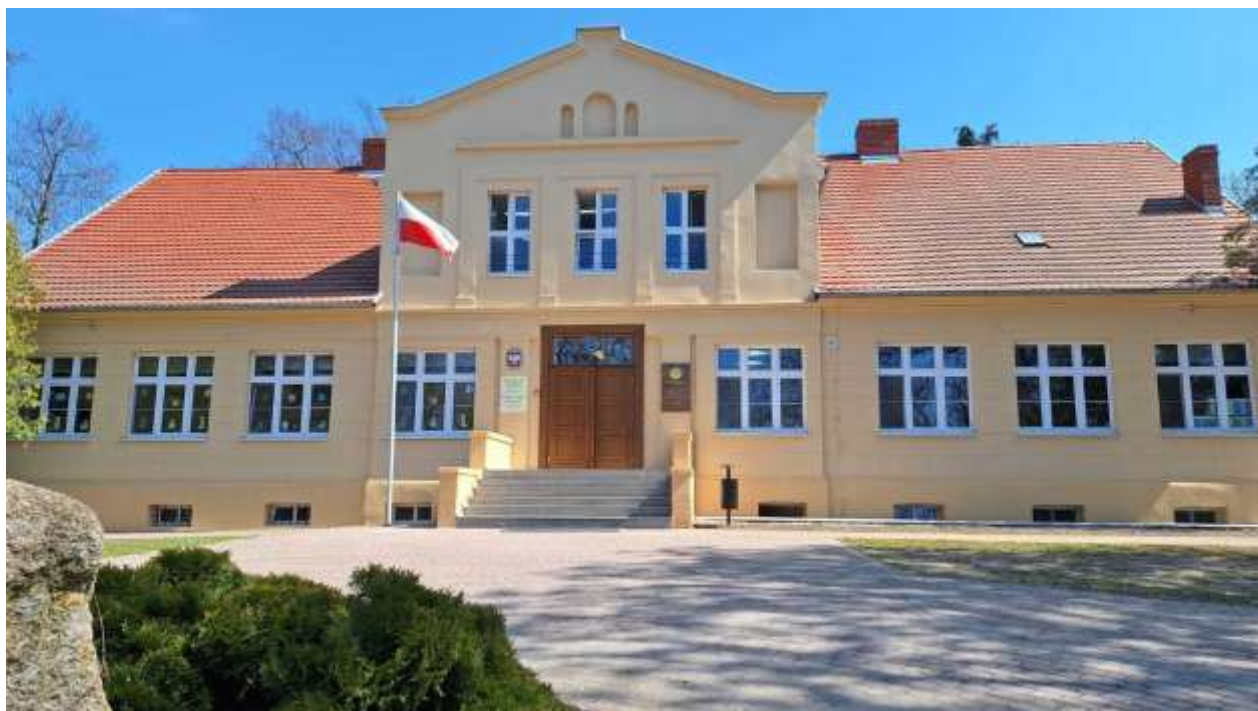
i po renowacji elewacji budynku zabytkowego dworu w Chrzęstowie
