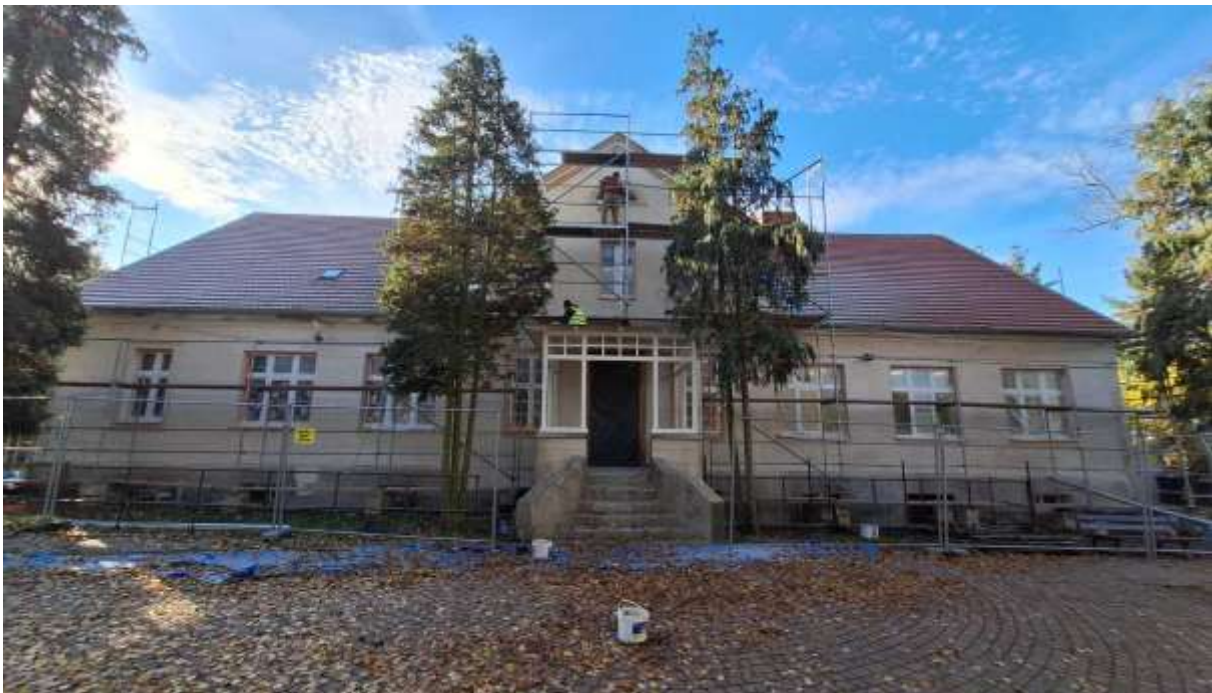
Budynek przed renowacją elewacji
