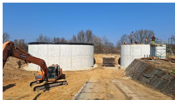
Rozbudowa i modernizacja oczyszczalni ścieków w Kiełczyńku
