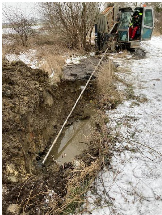
Prace remontowe kolektora ściekowego
