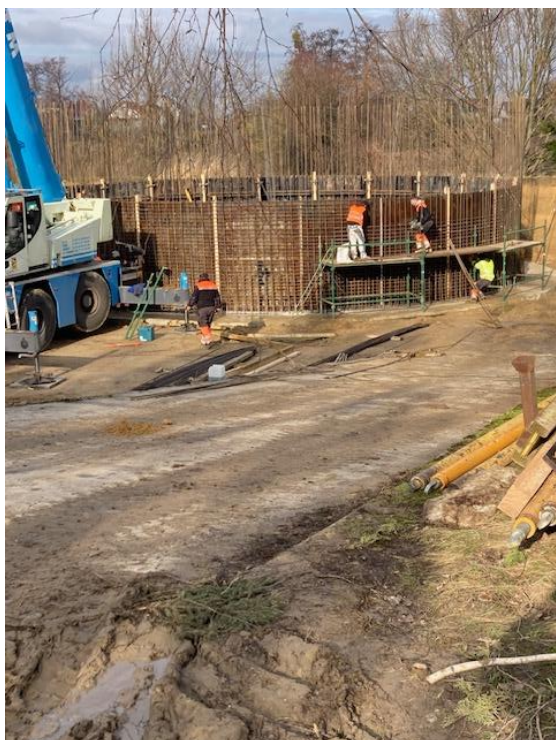
Modernizacja oczyszczalni ścieków
