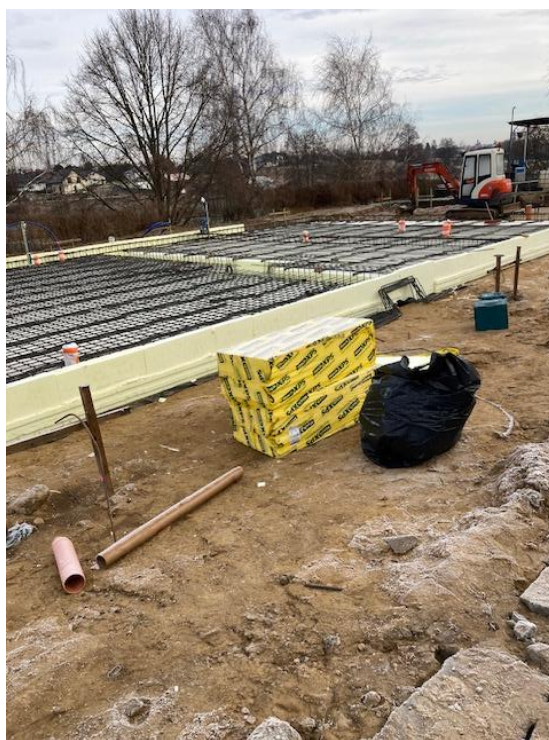
Modernizacja oczyszczalni ścieków
