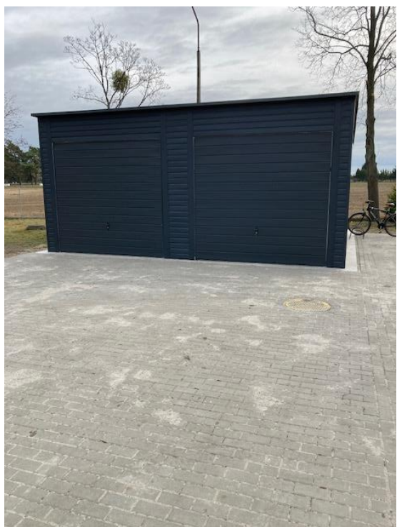
Garaż na Stacji Uzdatniania Wody w Książu Wlkp.
