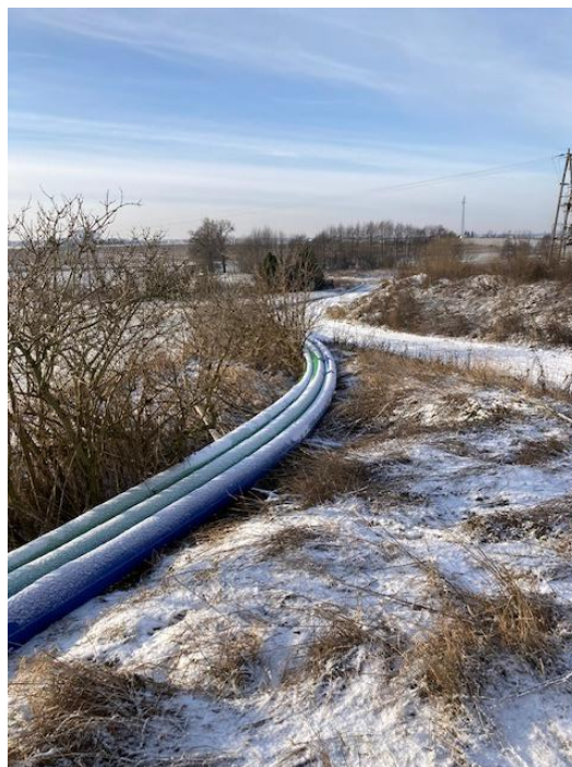
Prace remontowe kolektora ściekowego
