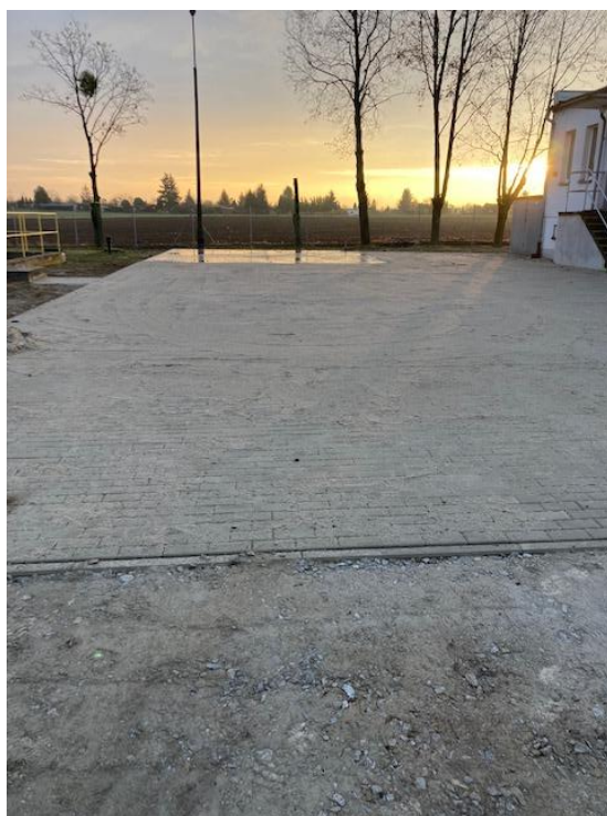
Podjazd i plac przed Stacją Uzdatniania Wody w Książu Wlkp.
