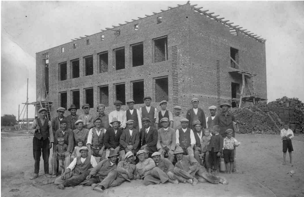
Budowa szkoły w Książu (1935 rok)
